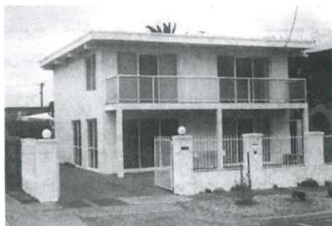
شکل ۱۲- نمونه‌ی ساختمان ساخته شده با سقف مستوی
